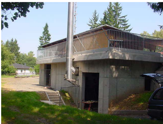
Außenansicht Kessel- und Lagerraum
