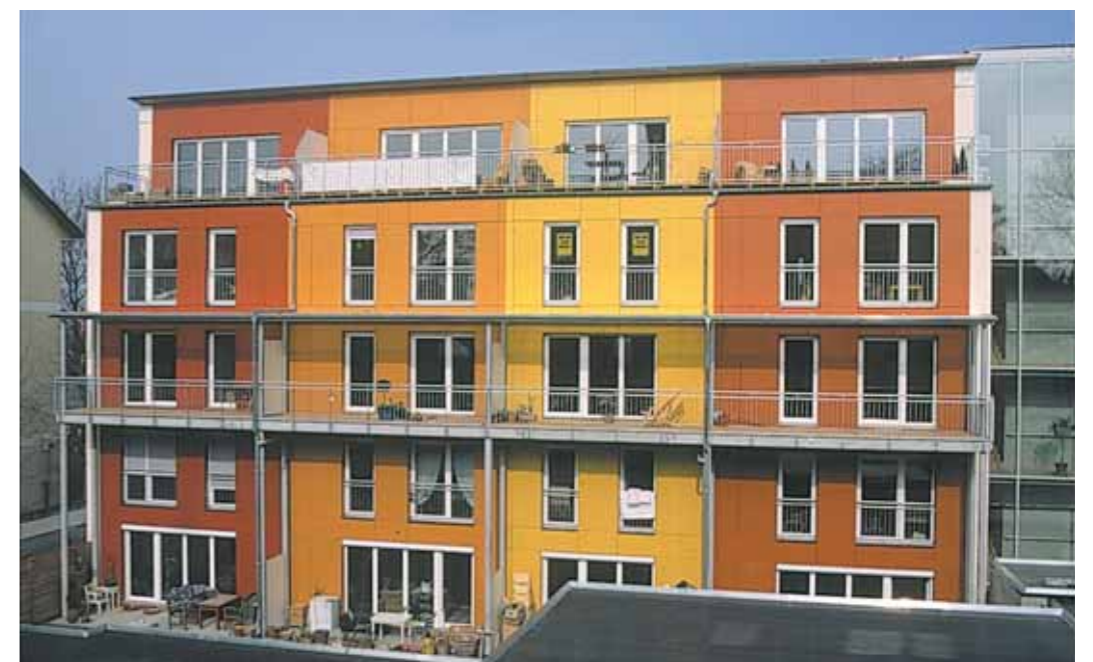
Passivhaus-Geschosswohnungen Grepstraße. Foto: ABG Frankfurt Holding GmbH
