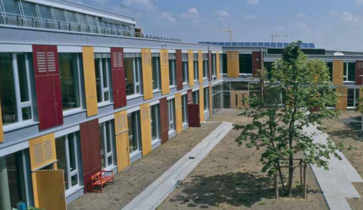
Grundschule Riedberg. Foto: Christian Kandzia, Stuttgart
