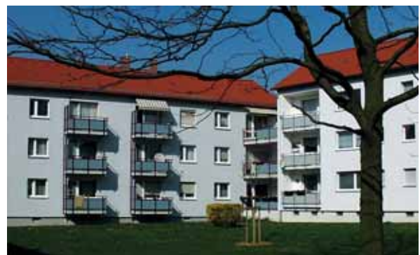
Zusätzlich zur Wärmedämmung erfolgt die Wärmeversorgung der modernisierten Gebäude mit einem BHKW.
