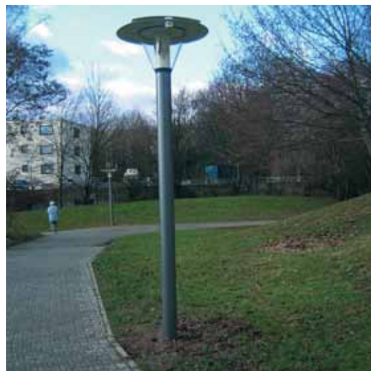
In einem Pilotprojekt wurden im Jahr 2004 sechs Solarleuchten in einem Frankfurter Park installiert.
