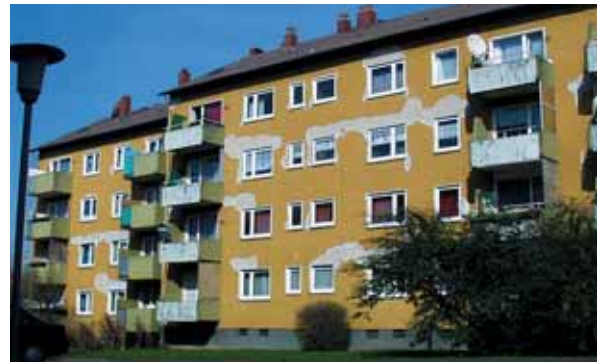
Die Karl-Kirchner-Siedlung vor und nach der Modernisierung
