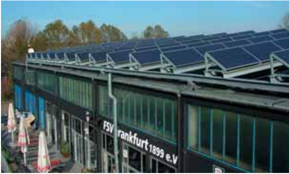
PV-Anlage der Mainova AG auf dem Tribünendach des FSV-Sportplatzes finanziert mit Mitteln der Mehreinnahmen des Stromangebots ÖKAWE
