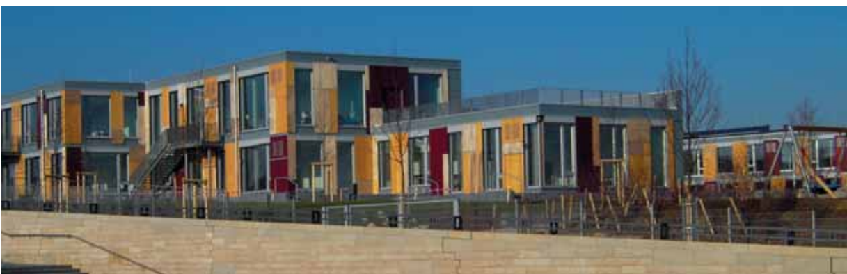
Die neue Grundschule am Riedberg wurde als erste Schule in Deutschland vollständig als Passivhaus gebaut. Die Mainova AG hat auf der Schule eine PV-Anlage errichtet, gefördert aus den Kundenmitteln des Ökostroms ÖKAWE.
