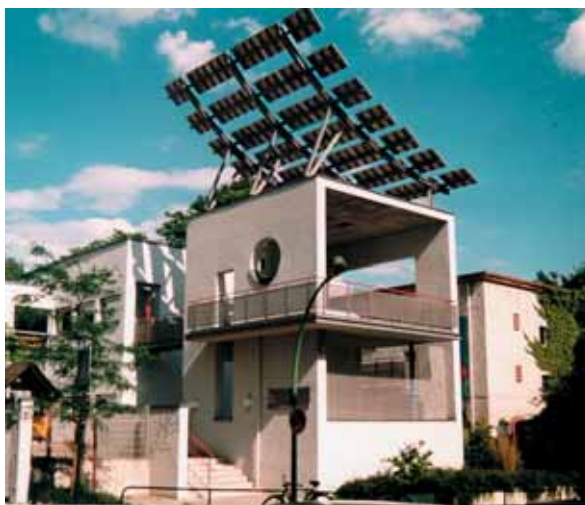
PV kann auch architektonisch interessant sein, wie bei der Kita 126 in der Rendeler Straße
